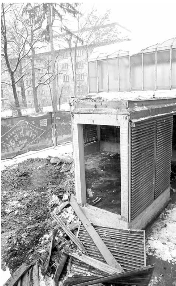
Der Eingang im Abbruch Foto ©Kozman
