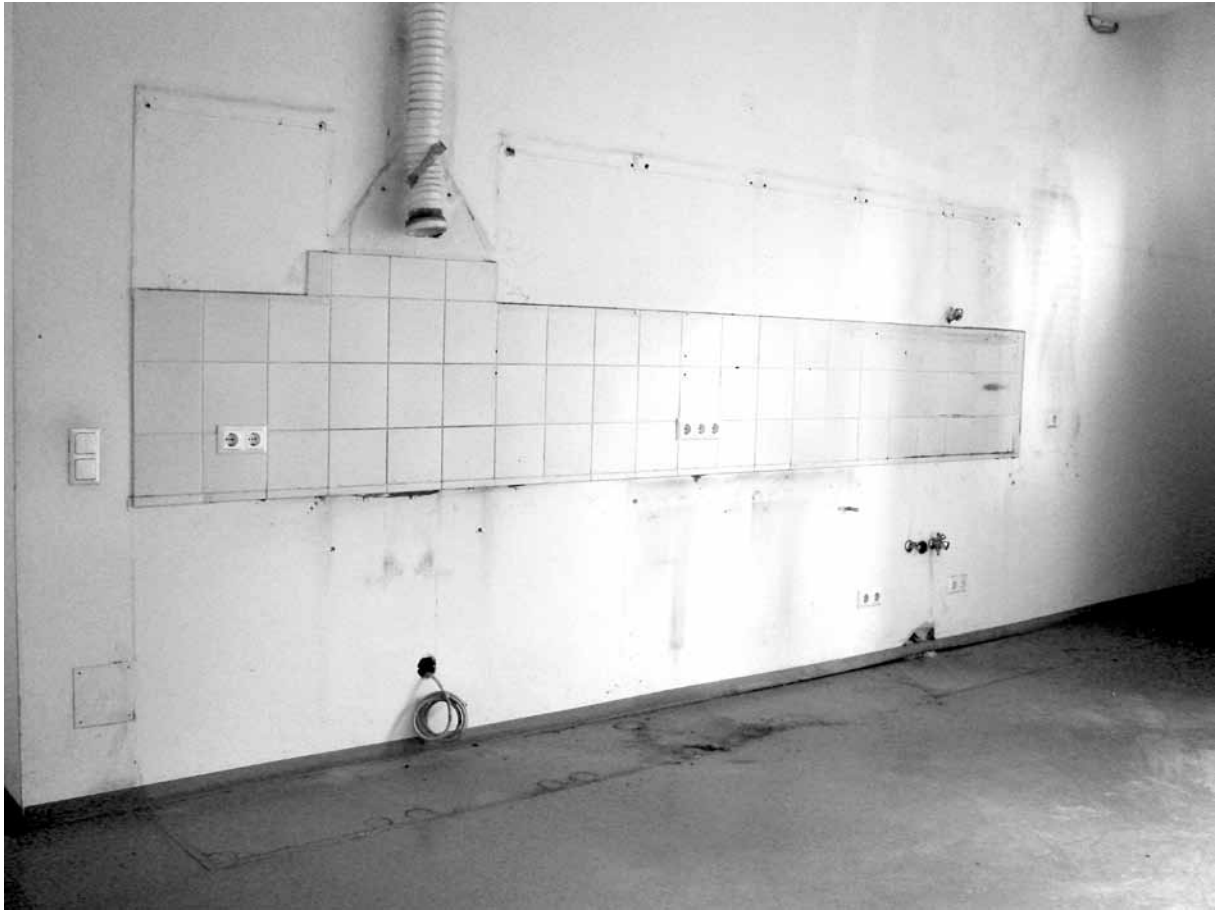
Ehemalige Stockwerksküche im KHG-Heim. Foto © Pinaeva
